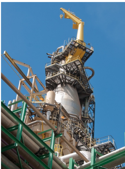
Figura 2.1.4.5.1-3. Digestor de cozimento dos cavacos de madeira.
