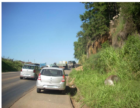
Figura 2.3.1.3.1-7: Talude de corte na Rodovia PR-160/Município de Telêmaco Borba, mostrando queda de blocos de arenito cimentado, destacados de sua camada sub-horizontal.
