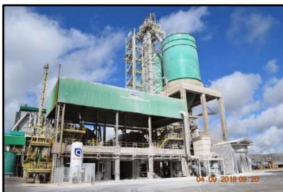
Figura 18 - Forno de cal instalado.
