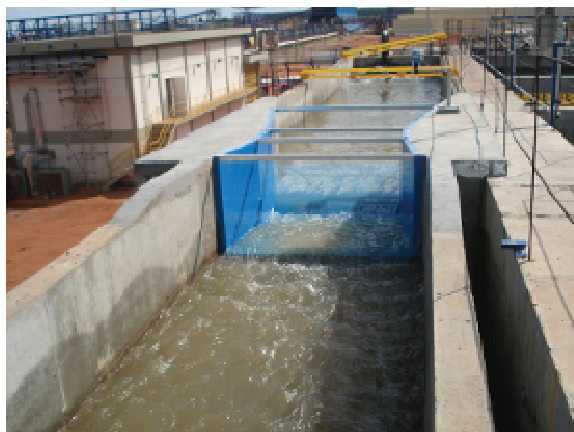
Figura 3.4/7 - Calha Parschall da linha 1.
