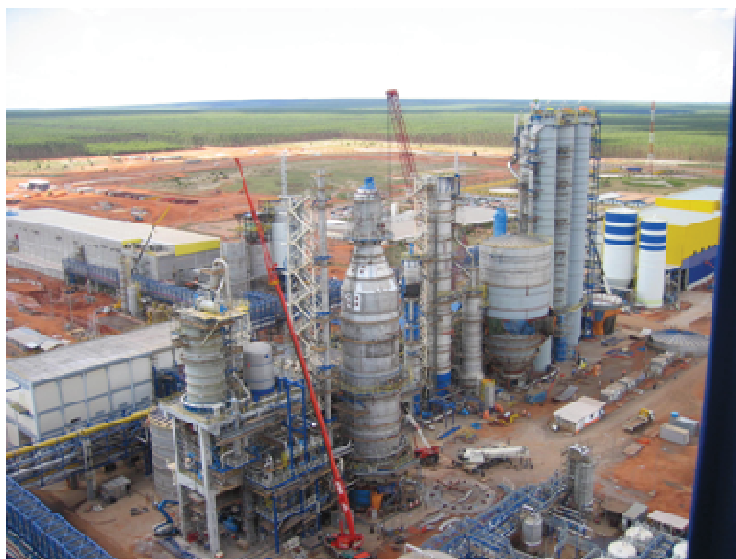
Figura 3.4/2 -Linha de fibra – montagem linha 1.
