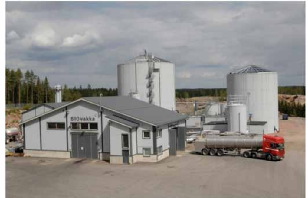
Vehmaan biokaasulaitos otettiin käyttöön vuonna 2005. Laitoksen sianlietteiden ja elintarviketeollisuuden sivuvirtojen käsittelykapasiteetti on 120 000 tonnia/vuosi ja sen teho on 4 MW.
